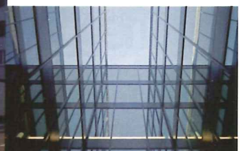
Hartmann setzt visionäre Architektur um: Fassadenbau
