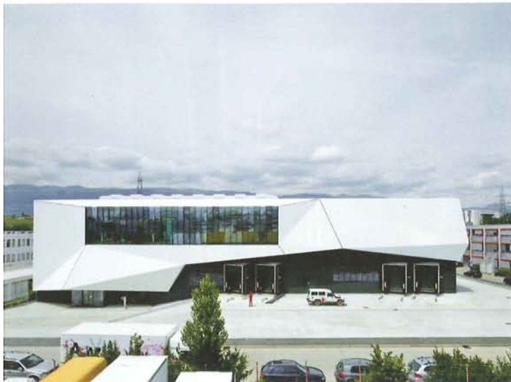
Eine weisse LKW-Plane umhüllt das Logistikzentrum
