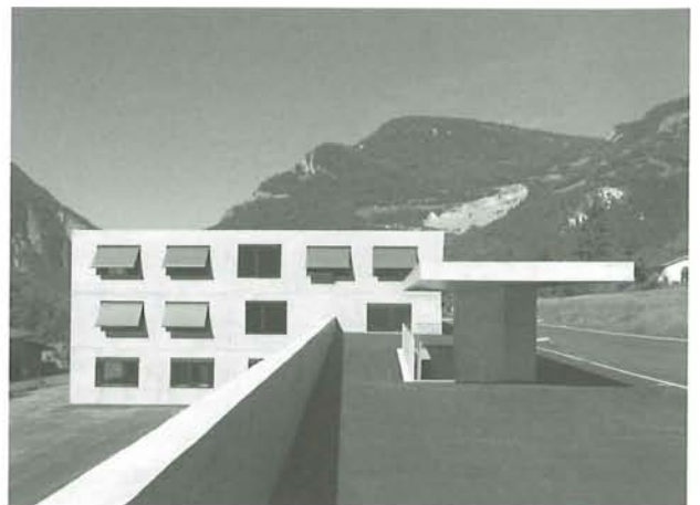
Façade est depuis le niveau de la route
